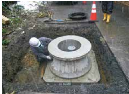
空気弁の更新（中支線 5箇所）
