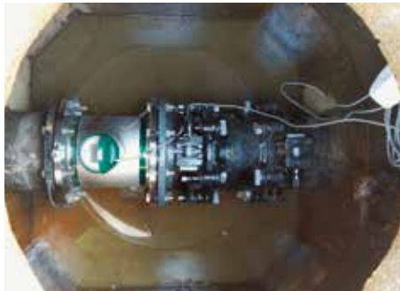
流量計の更新（上野支線 2箇所）
