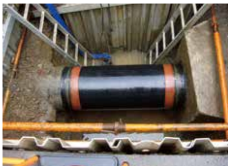
漏水箇所の補修（中支線φ600mm 2箇所）
