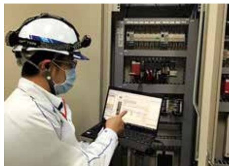
水管理システムの保守点検
